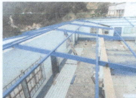
Colocación de estructura de metal
