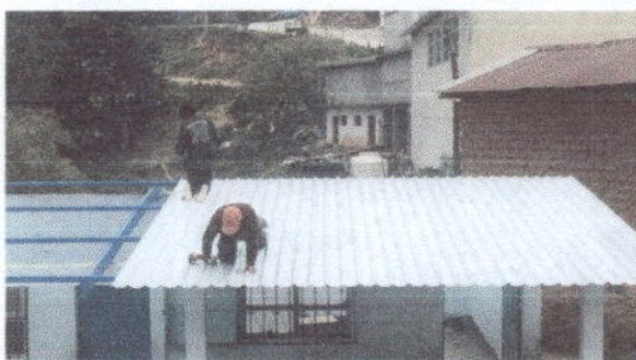
Colocación de la lamina
